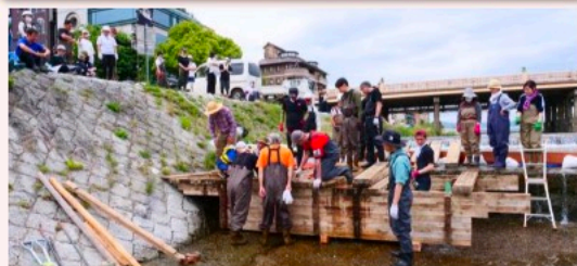
令和5年4月29日(土) 魚道設置の様子
